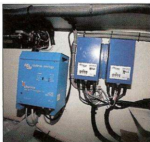
Un variateur pour chaque moteur. A côté du chargeur de batterie, les variateurs gèrent les moteurs.
